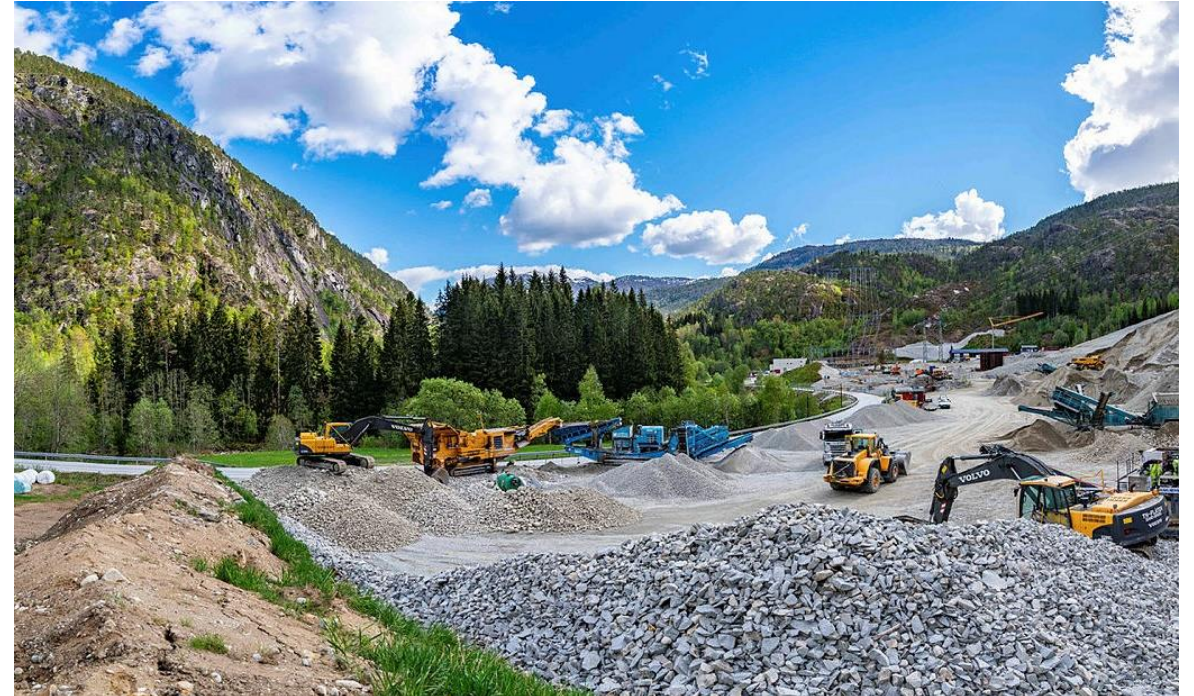
Anleggsarbeid, Leirdøla stasjon: Fornyelse og økt transformeringskapasitet
