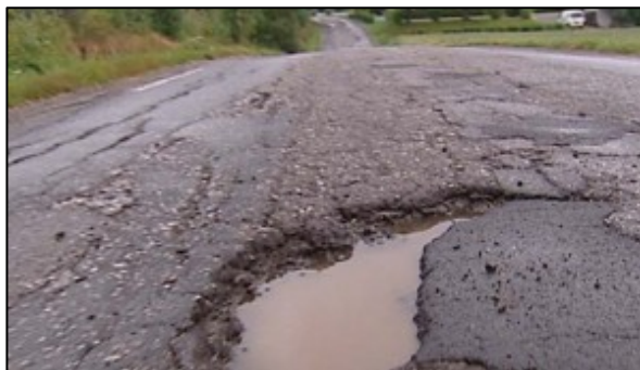
Bilete 1: Illustrasjonsfoto, behov for vedlikehald (Statens vegvesen)
